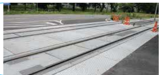
▲軌道整備イメージ:清原工業団地内
