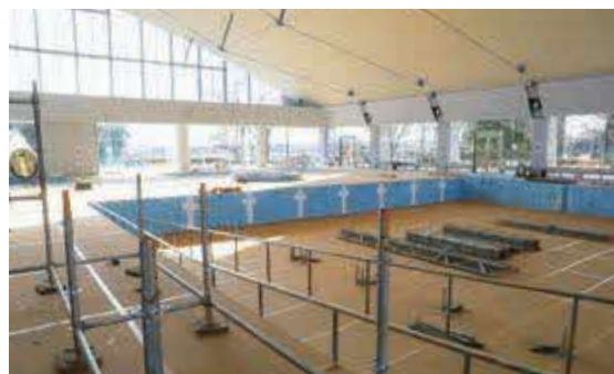
▲工事が始まった館内
