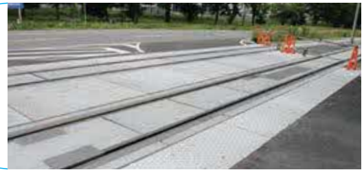
▲軌道整備イメージ:清原工業団地内
