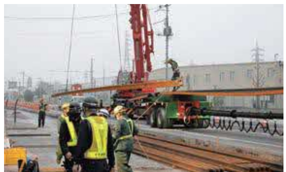
▲工事が進む区間内
