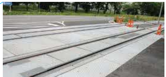
▲軌道整備イメージ:清原工業団地内
