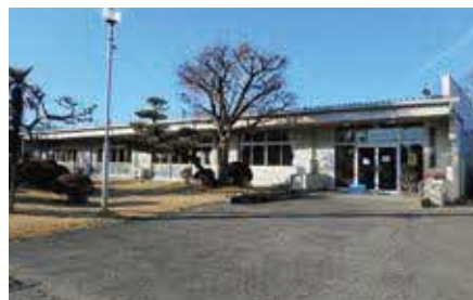
▲改修工事が行われる 生涯学習センター水橋分館
