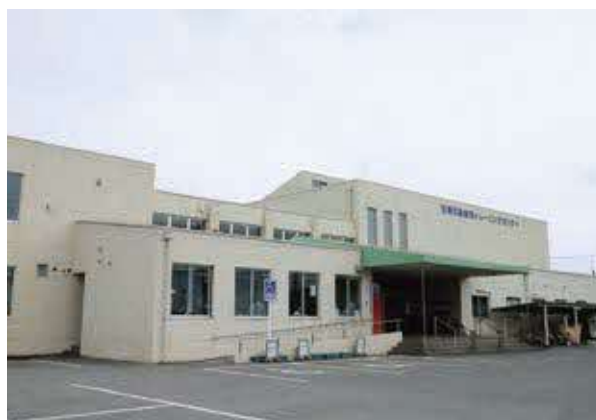
▲築42年が経過した農業者トレーニングセンター
