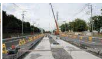
▲LRT工事が進む現場
