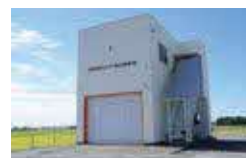
▲工事が完了した2-3(芳志戸)
