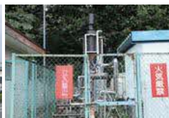
▲ポンプ交換を行った第1号源泉
