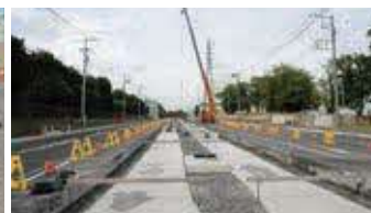
▲LRT工事が進む現場
