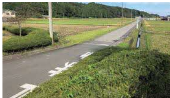
▲工事する区間
