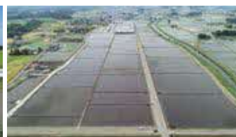
▲整備された北部第2地区ほ場
