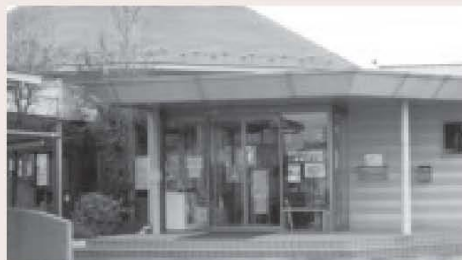
上高根沢ふれあいセンター (高根沢町図書館上高根沢分館)
