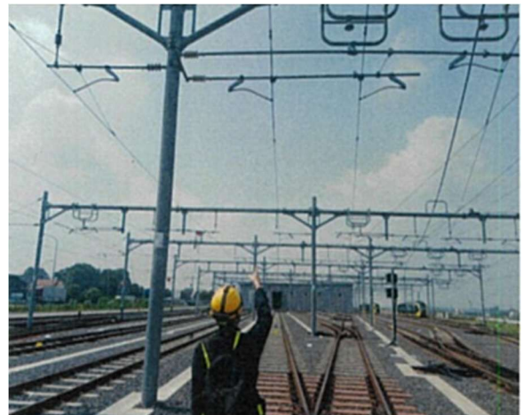
【電車線路設備巡視点検】
