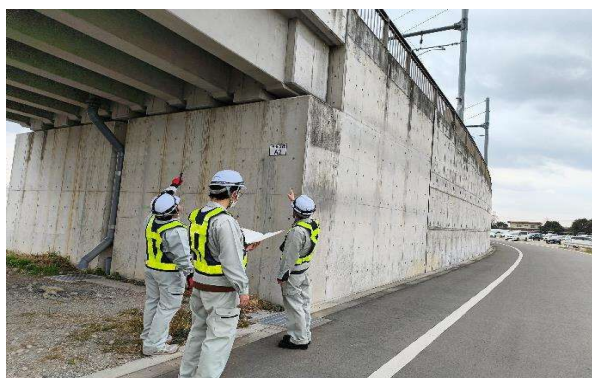
【構造物の点検方法の確認の様子】
