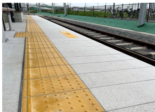
【ホームの点字ブロック】
