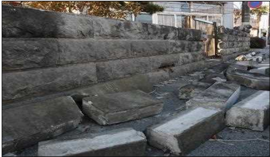
大谷石塀の倒壊
