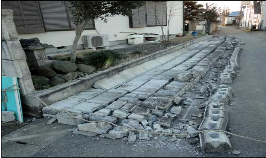
ブロック塀の倒壊
