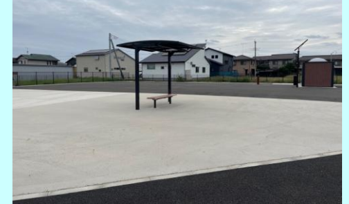
地域生活基盤施設(多目的広場)
