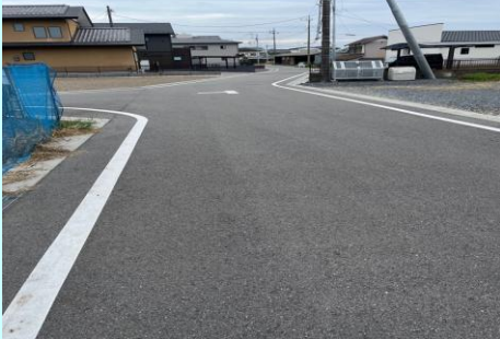
道路(町道2023号線)
