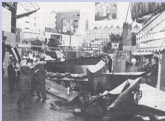
台風で落下した時の様子
