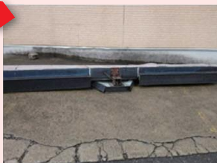
落下した欄間看板
